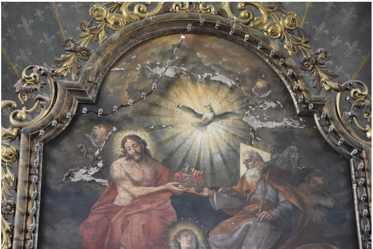
Fotografie stavu před opravou dokládá rozsah odlupujících se tmelů z opravy 1905-06. Ty se soustřeďují na horní polovinu obrazu.
